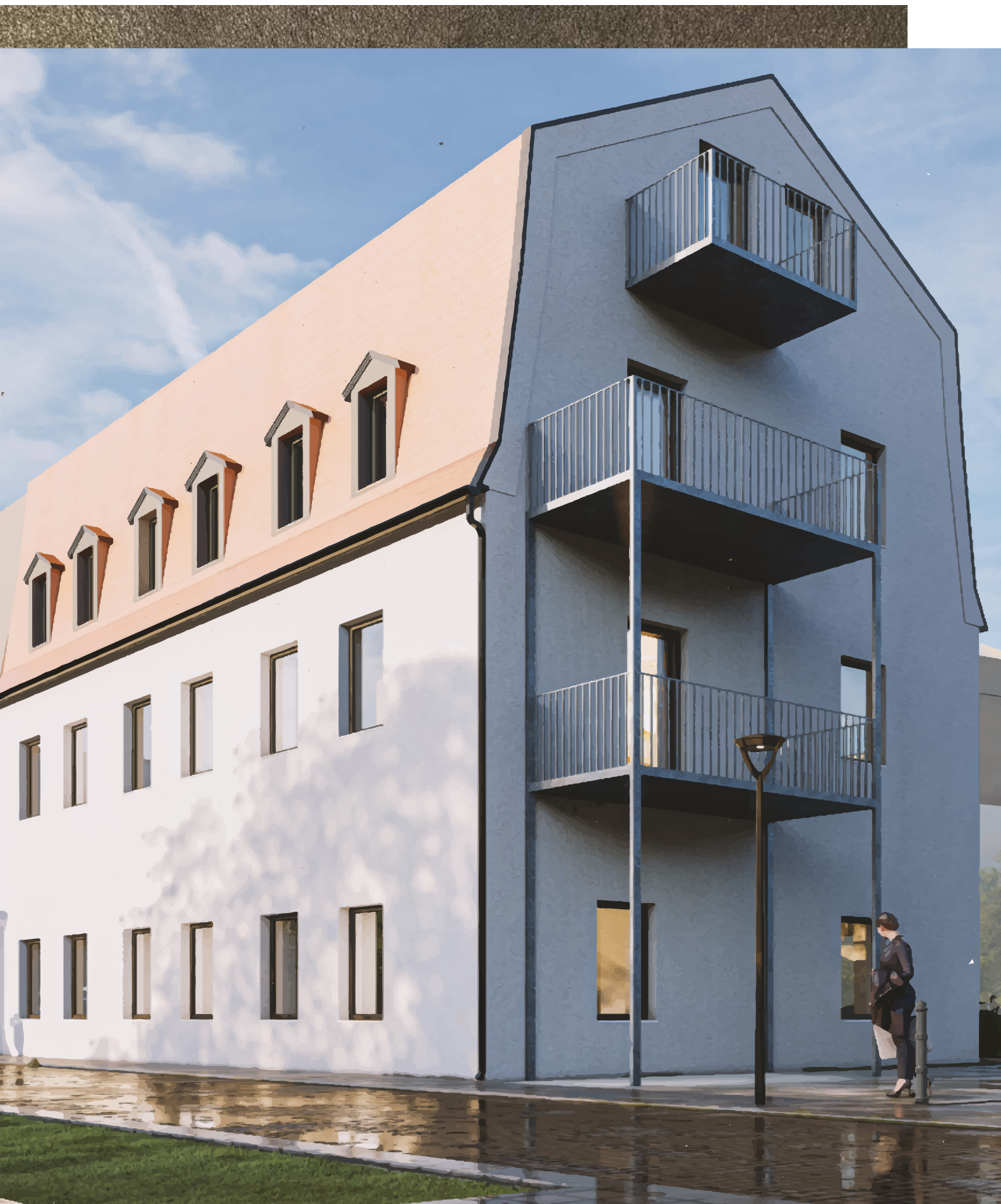
UNVERBINDLICHE ILLUSTRATION NACH SANIERUNG
